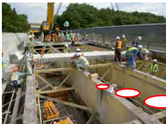
プレキャスト床版設置
