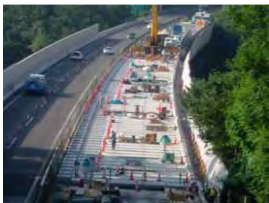
工事全体写真
