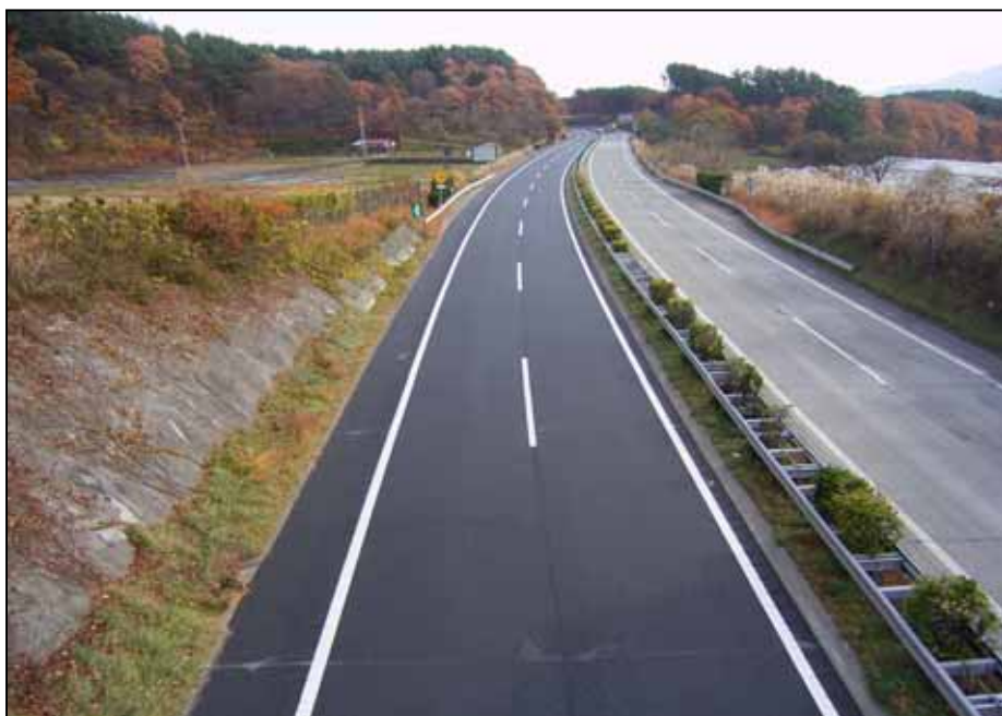
工事後（アスファルト舗装）
