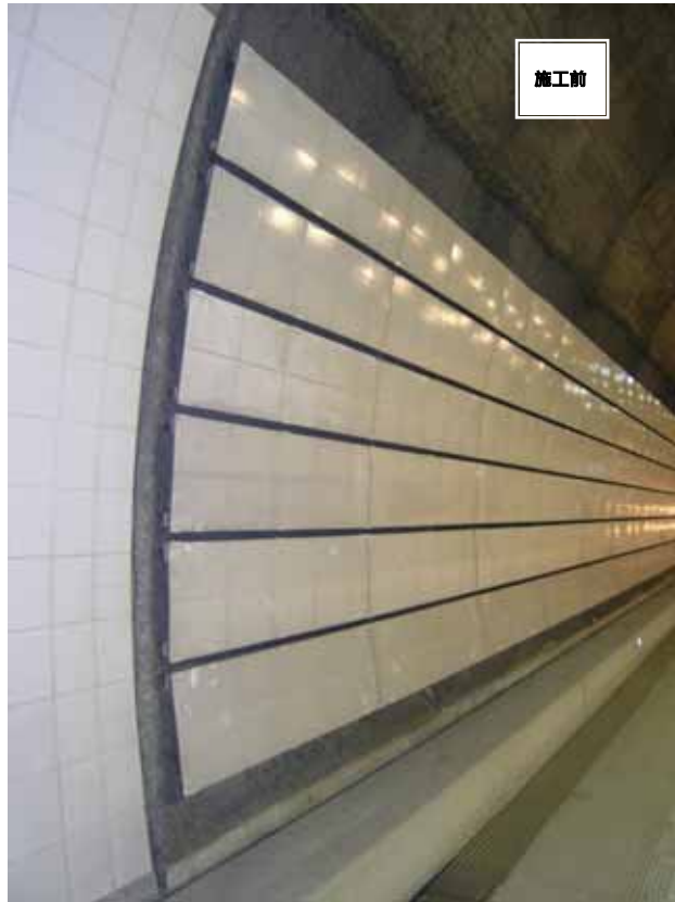
( 飛驒トンネルのタイルパネル補強対策写真 )
