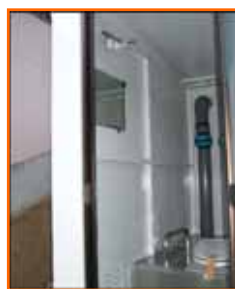
＜バイオトイレ内装＞
