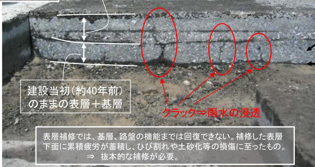
表層補修では、基層、路盤の機能までは回復できない。補修した表層下面に累積疲労が蓄積し、ひび割れや土砂化等の損傷に至ったもの。
