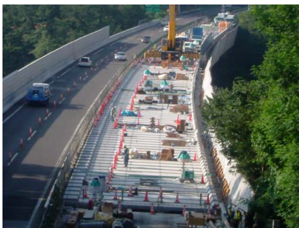
工事全体写真（他工事事例）
