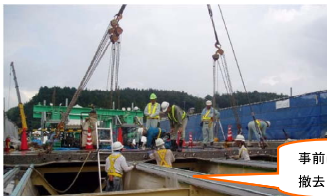
プレキャスト床版設置状況（他工事事例）
