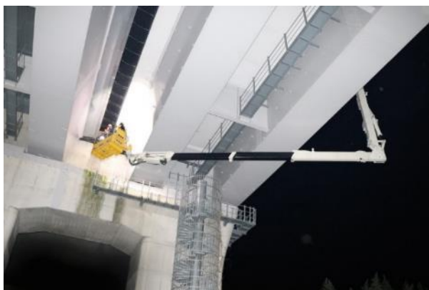
橋梁の点検状況
