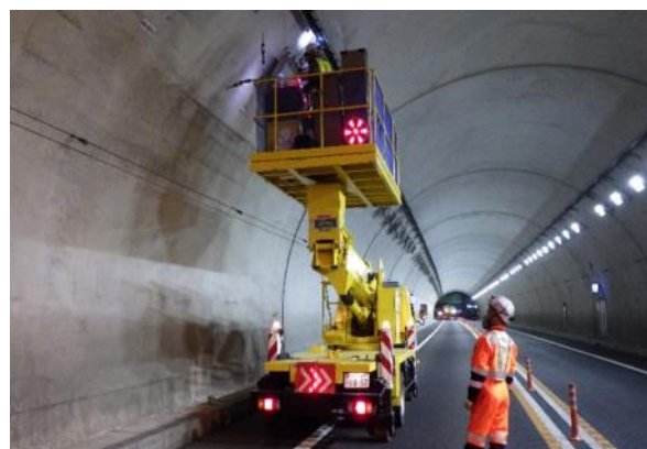
トンネル照明設備の清掃状況
