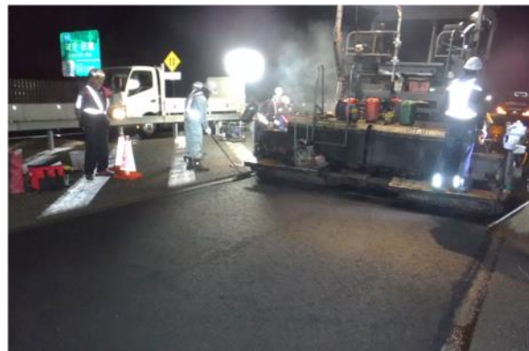
舗装補修の工事状況
