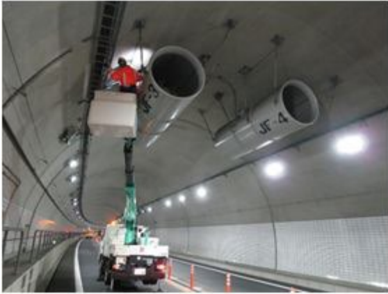
<トンネル点検>
