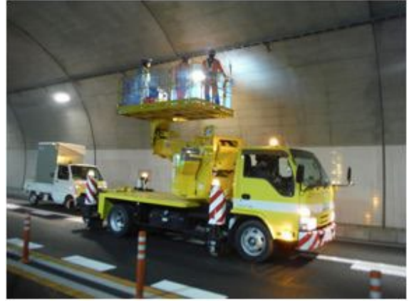
<トンネル照明設備点検>
