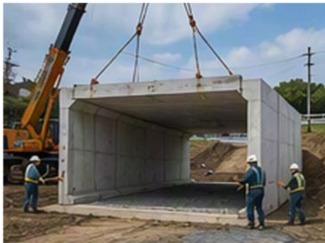
カルバートボックス据付(頂版部)の状況
