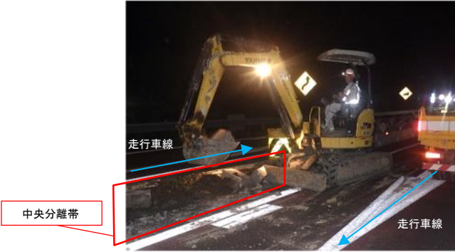
中央分離帯撤去の状況
