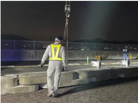
仮設防護柵設置の状況
