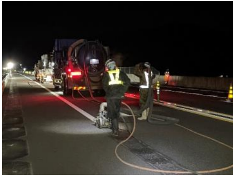
区画線消去・明示の状況
