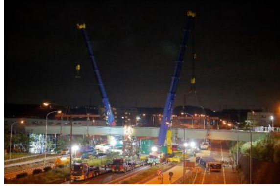
大型クレーンによる跨高速道路橋の 撤去作業（イメージ）
