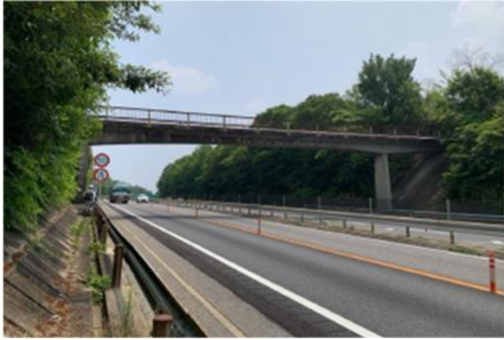
撤去する長瀬橋（多治見市管理）
