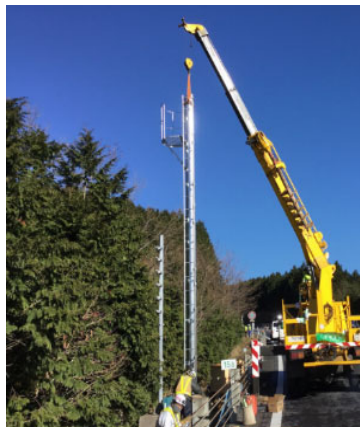
CCTV カメラ設備 設置状況
