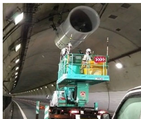
ジェットファンの点検状況
