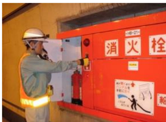
トンネル非常用設備の点検状況
