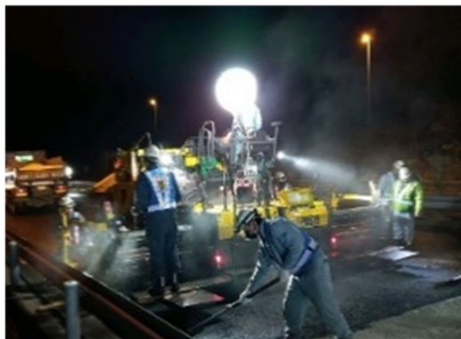
舗装の補修状況
