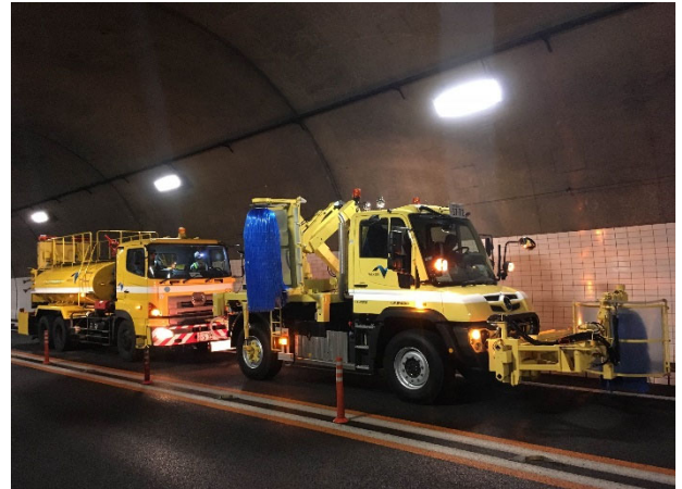
トンネル側壁清掃(イメージ)
