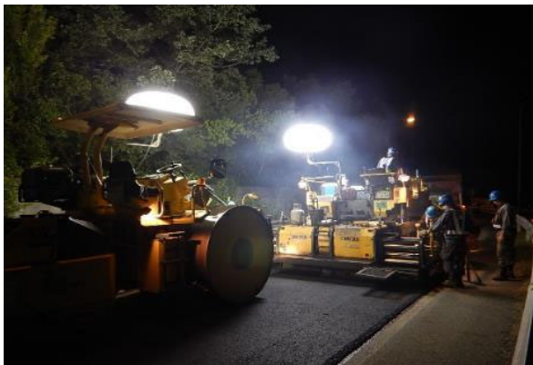
路面損傷箇所の補修(イメージ)
