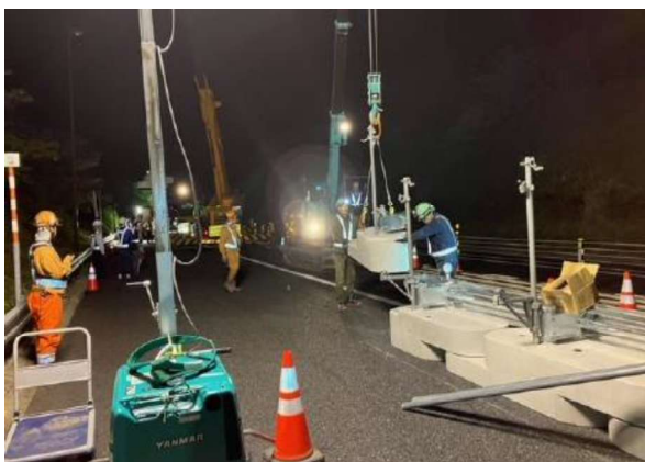
仮設防護柵設置(イメージ)
