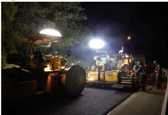
路面損傷箇所の補修(イメージ)
