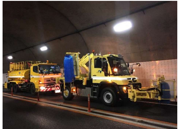
トンネル側壁清掃(イメージ)
