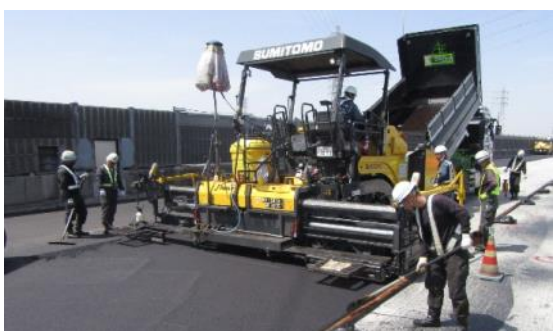
新たな舗装の施工状況
