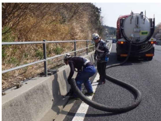
排水溝の清掃
