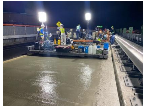
SFRC 舗装の施工状況
