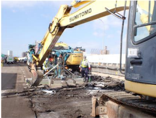
劣化した舗装の剥ぎ取り状況
