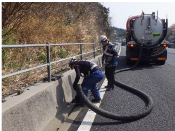
排水溝の清掃
