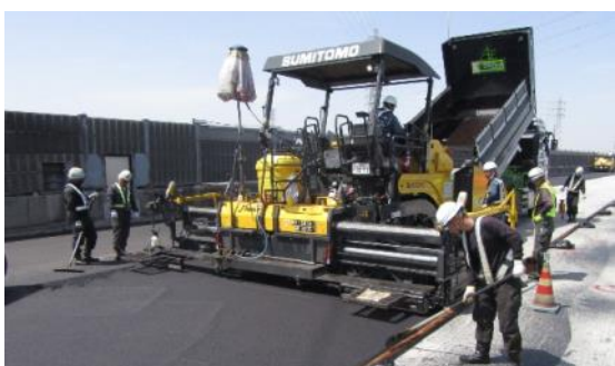
新たな舗装の施工状況
