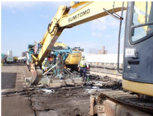
劣化した舗装の剥ぎ取り状況
