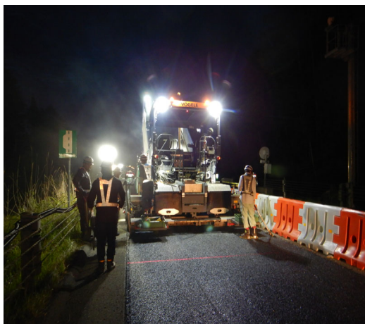
舗装補修工事(イメージ)
