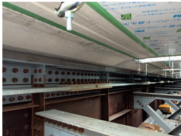
下り線走行車線側の橋桁改良
