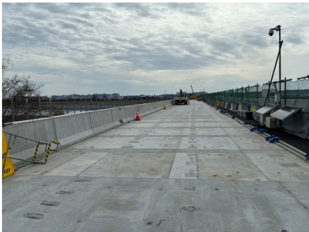
下り線走行車線側の床版取替
