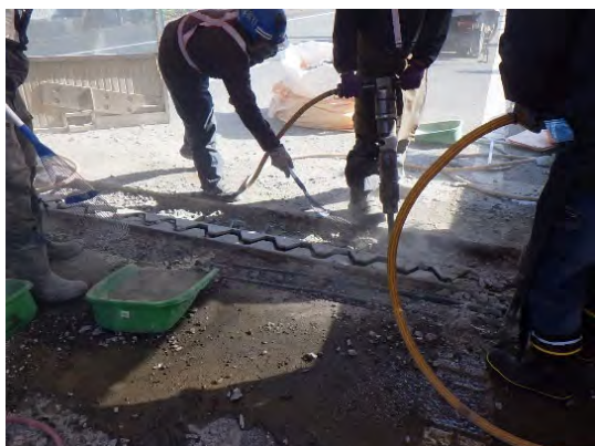
伸縮装置取替工事（イメージ）
