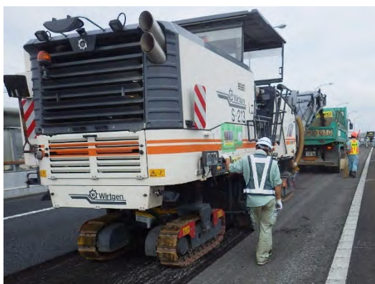
舗装補修工事（イメージ）
