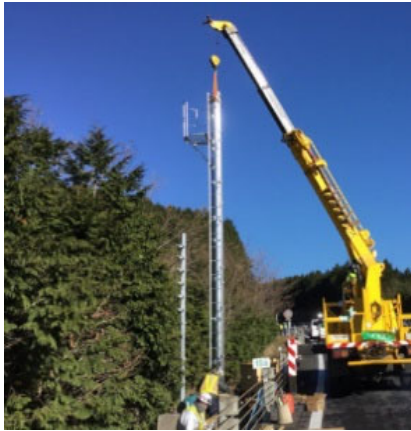
CCTV カメラ設置工事
