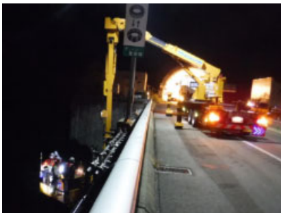
特殊点検車両による橋梁点検
