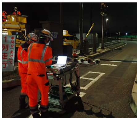
ETC 設備の点検状況
