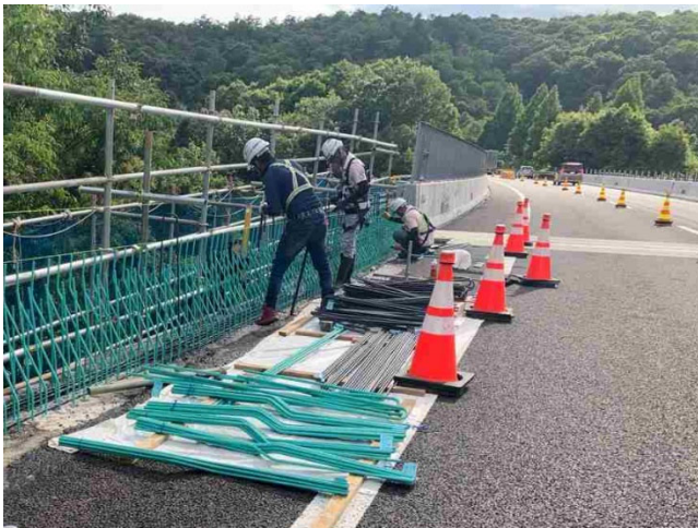
壁高欄の打ち換え工事(イメージ)
