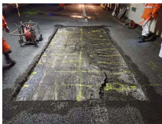
床版上面の状況
