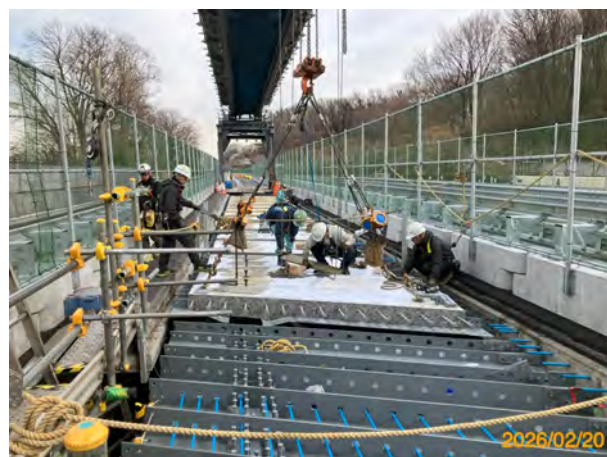
新しい床版の設置
