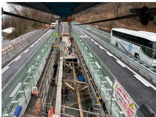
老朽化した床版の撤去
