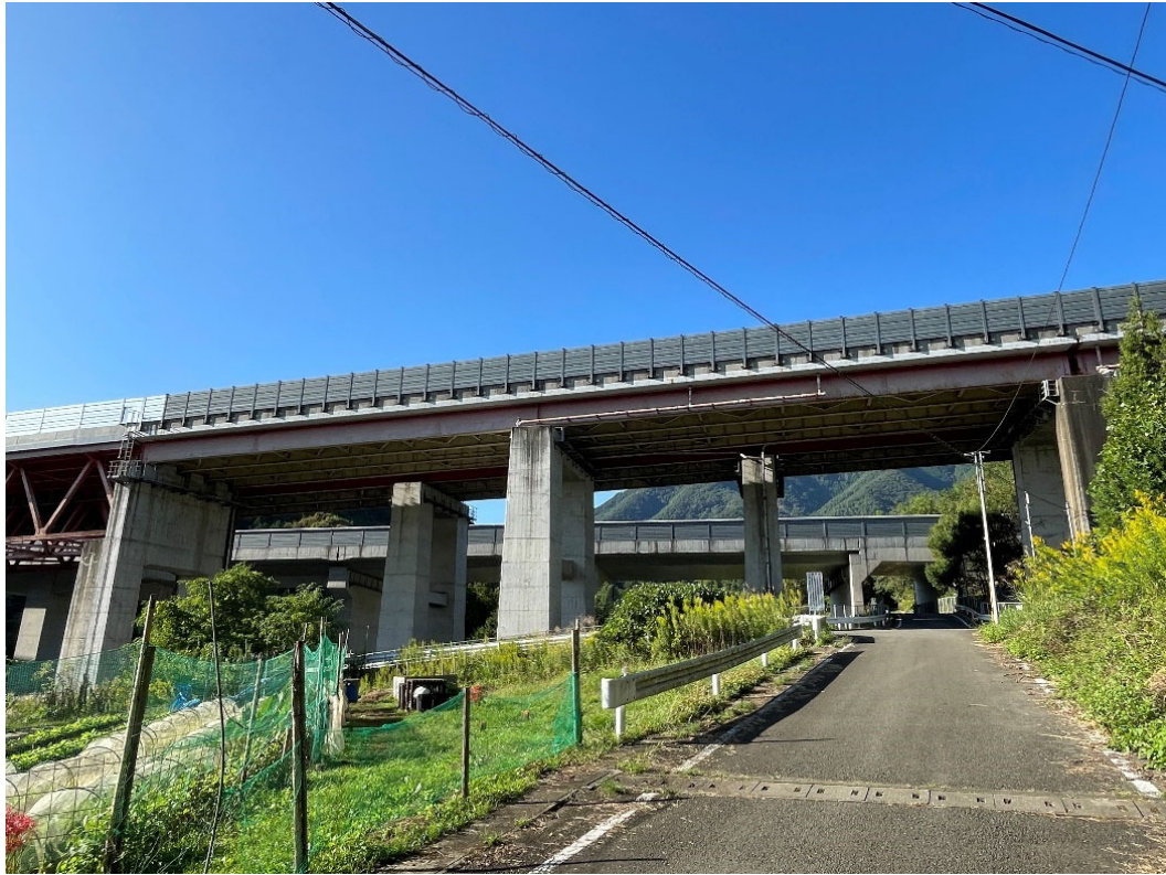
＜中野橋(下り線・左ルート)の橋梁全景＞
