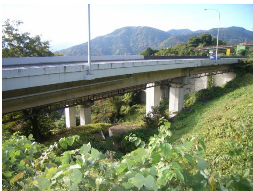
<堰口橋の橋梁全景>
