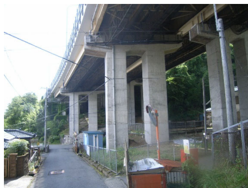
<滝沢川橋(小山)の橋梁全景>
