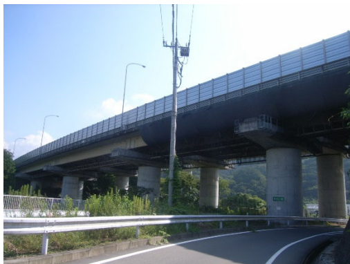
<馬伏川橋の橋梁全景>
