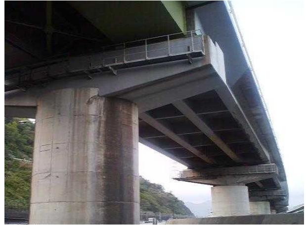
<薩埵高架橋の橋梁全景>
