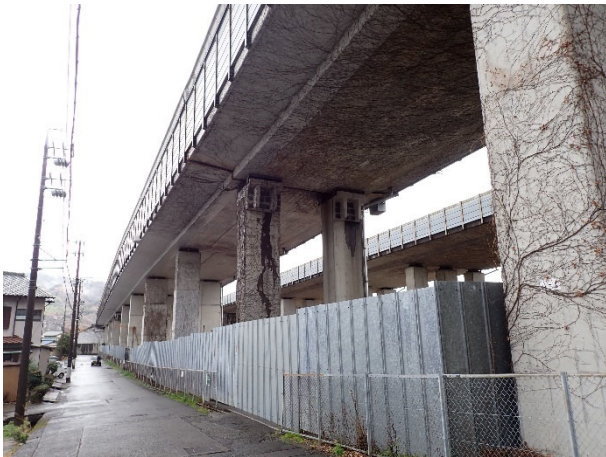
<八木間高架橋の橋梁全景>
