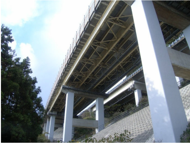
<中村高架橋の橋梁全景>
