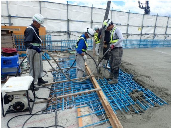
【現場打ち床版の施工状況】
