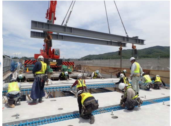
【プレキャストコンクリート床版の施工状況】
