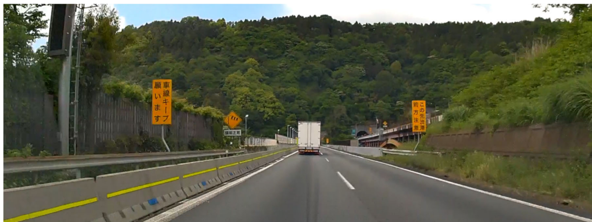
【吾妻山トンネル入口付近】
