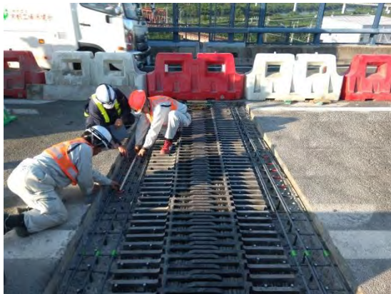
橋梁伸縮装置取替状況
