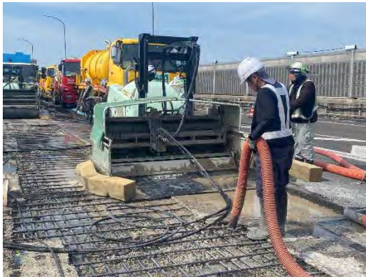
老朽化した床版の補修状況
