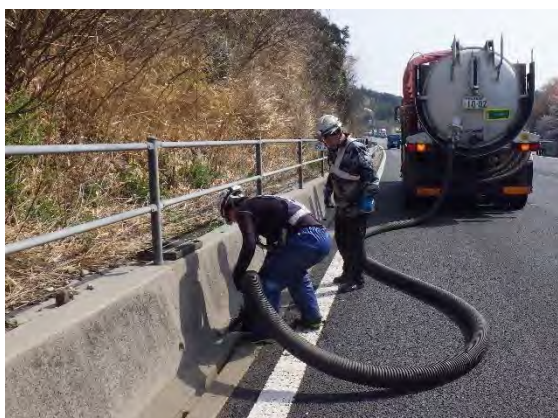
排水溝の清掃
