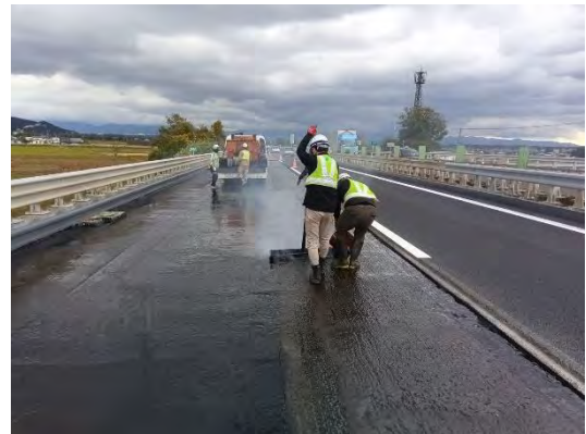
床版防水工の施工状況
