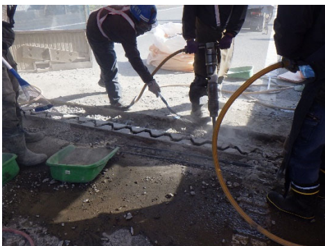
伸縮装置取替工事の施工状況（参考：過年度工事）
