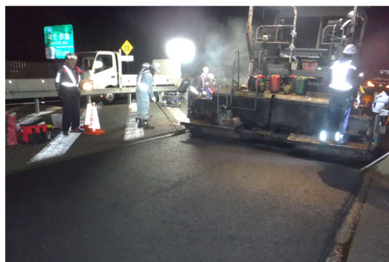
舗装補修工事(イメージ)
