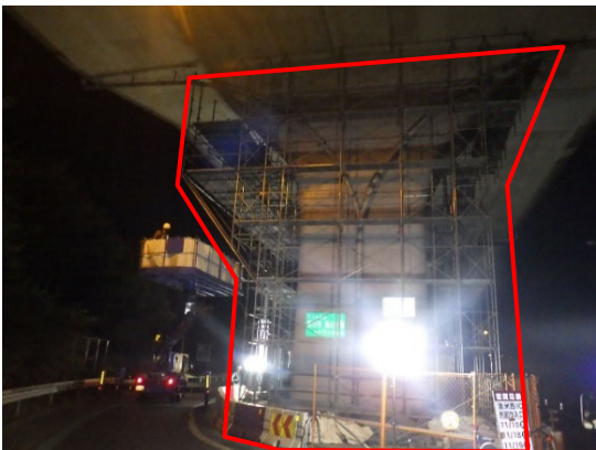
足場の撤去作業
