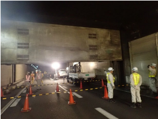
制水ゲートの点検
