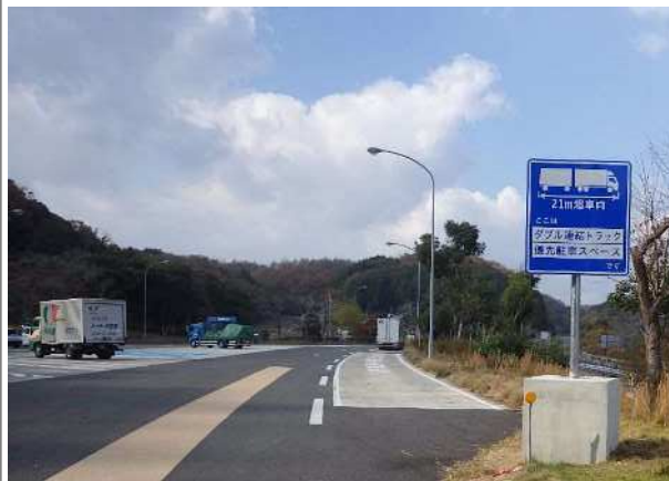
写真-1 E2A 中国道 江の川PA(下り線)
