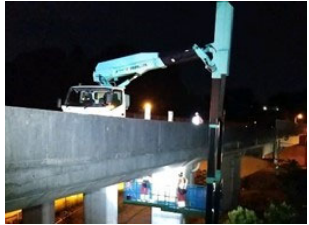
橋梁の点検状況
