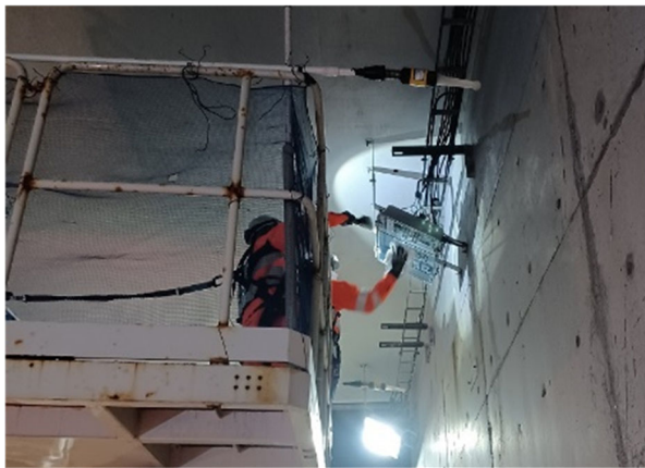
トンネル照明設備の灯具清掃状況
