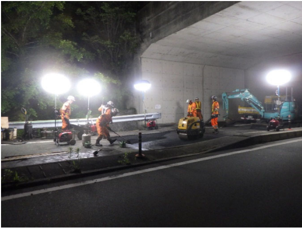
舗装の補修状況
