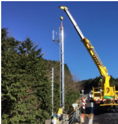
CCTV カメラ設置工事
