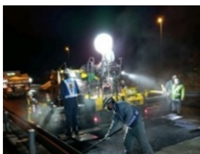
舗装補修工事
