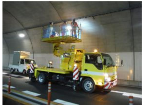
<トンネル照明設備点検>
