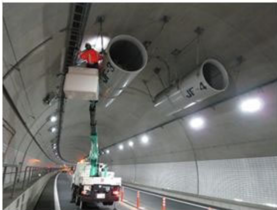
<トンネル点検>
