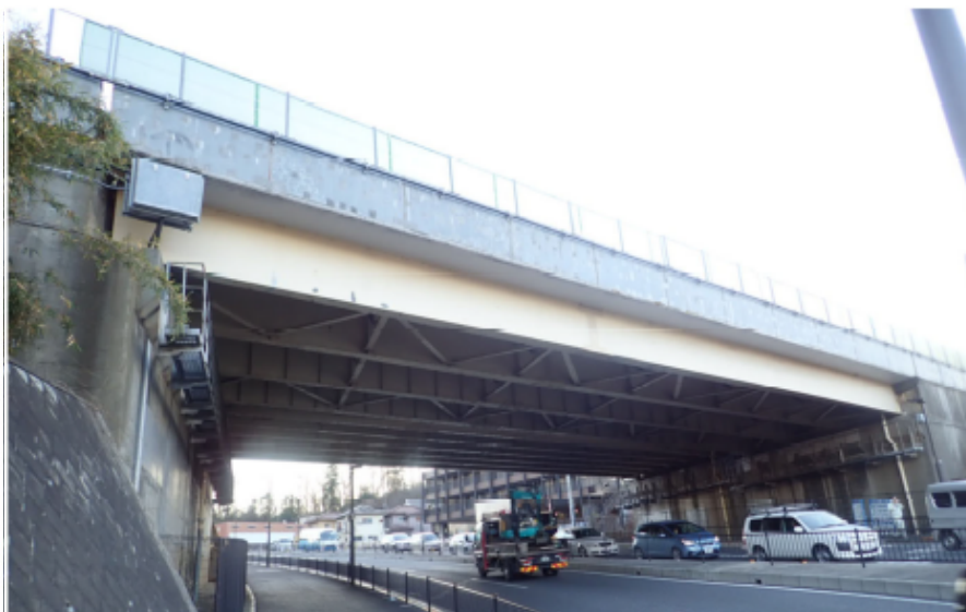
稲荷坂橋の橋梁全景
