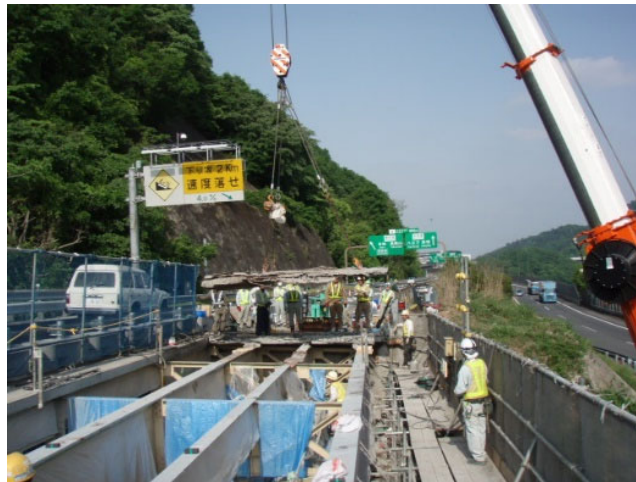
老朽化した床版の撤去
