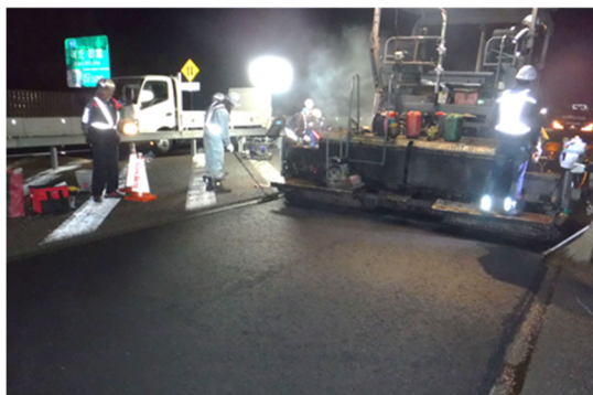
舗装の補修状況
