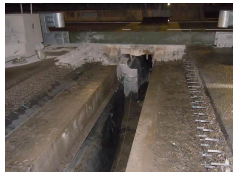
橋梁伸縮装置の撤去後の状況
