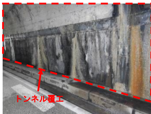
トンネル覆工の劣化状況
