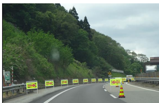
視認性のよい規制材の採用例
