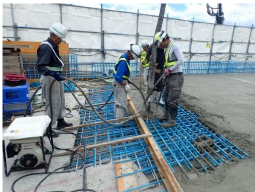
現場打ちコンクリート床版の施工
