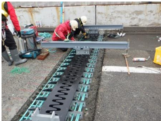
新しい伸縮装置の据え付け
