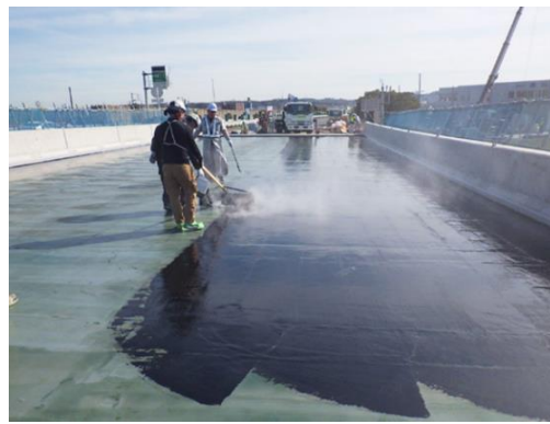
高性能床版防水の施工
