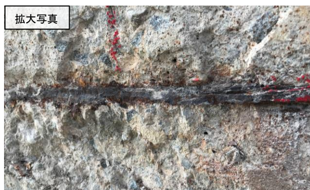
塩害による損傷が確認された橋台パラペット部(上り線)
