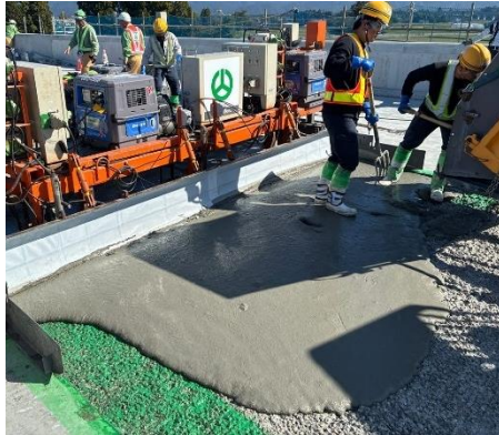
新しいコンクリートの打設
