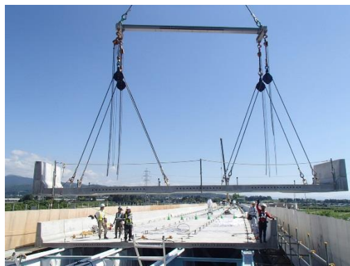
プレキャストコンクリート床版の施工
