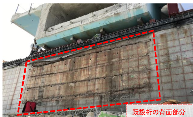
塩害による損傷が確認された橋台パラペット部(上り線)
