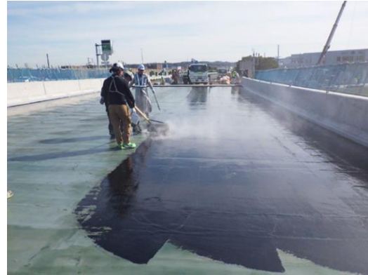
高性能床版防水の施工
