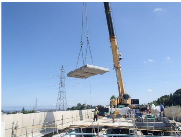
老朽化した床版の撤去
