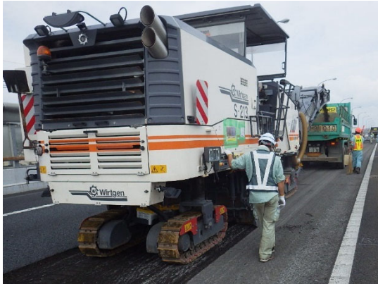
舗装補修工事(イメージ)
