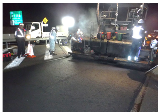
舗装の補修状況
