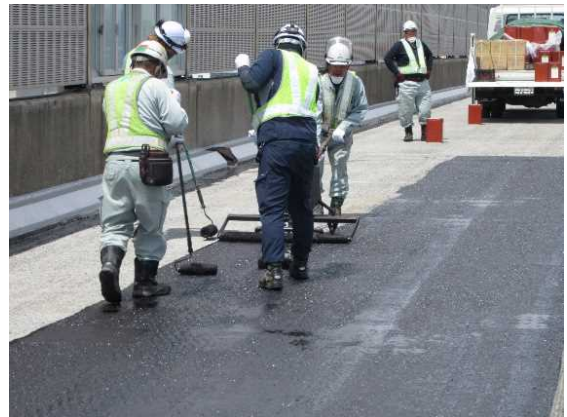
床版防水工の施工状況
