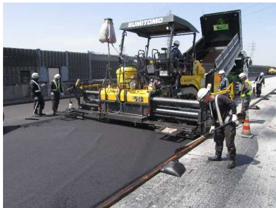
新たな舗装の施工状況
