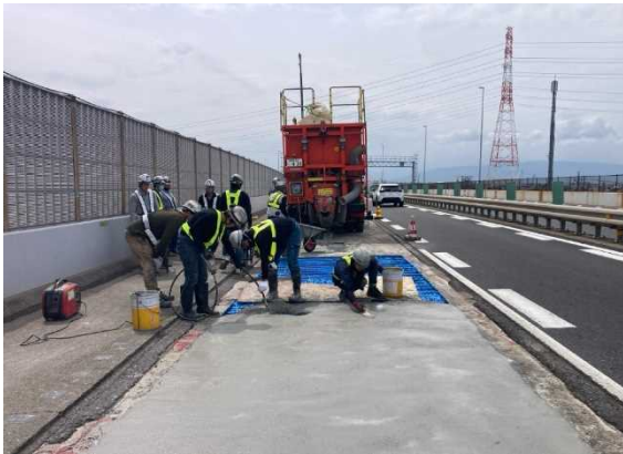
老朽化した床版の補修状況
