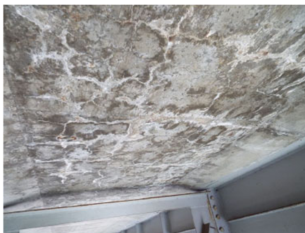
<中村川橋の損傷状況>
