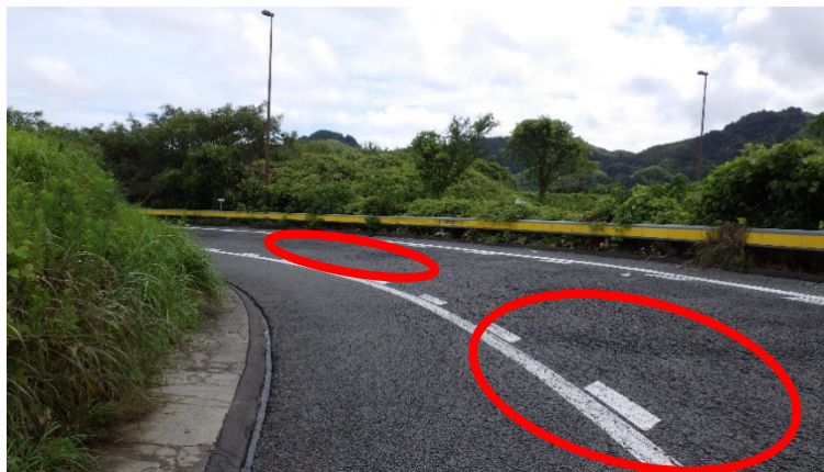
【藤枝 PA(上り)路面損傷状況】
