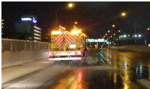
凍結防止溶液散布状況
