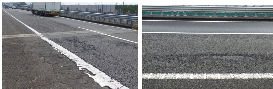
静岡 IC(上り線)入口付近の舗装損傷状況
