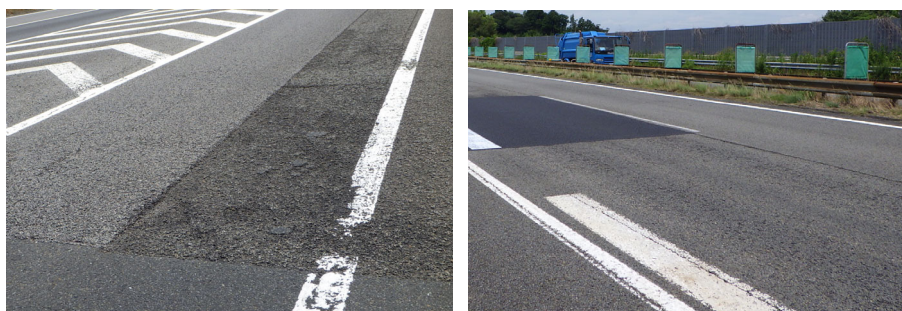
掛川 IC(下り線)出口付近の舗装損傷状況
