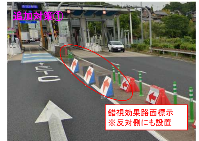
料金所開口部における矢印路面標示、矢印板を設置済
