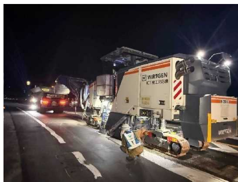
舗装工事イメージ
