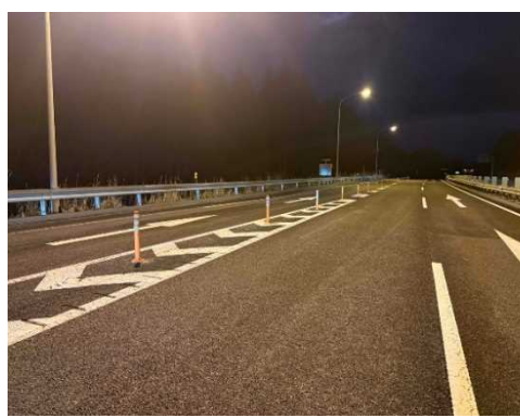
長野道(上り線)岡谷 IC 車線分離標設置状況
