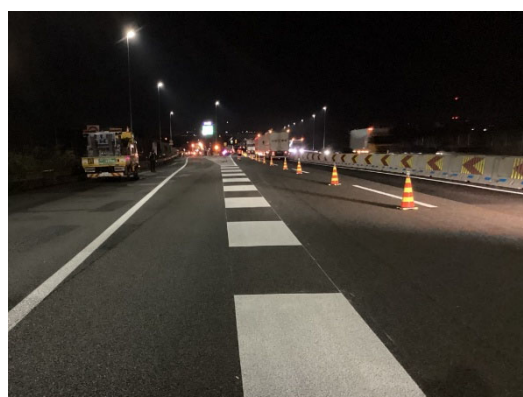
路面標示の書き換え状況（施工後）
