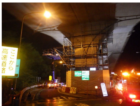
足場設置工事中の状況(8月実施)
