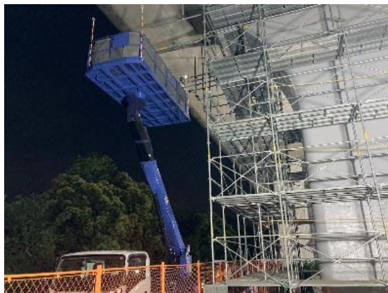
足場の撤去状況の例
