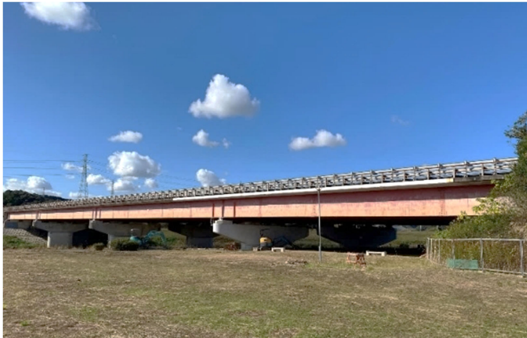
太田川橋の全景
